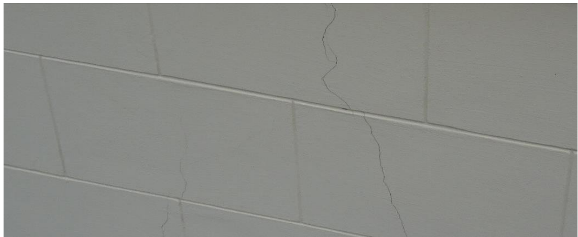
Obrázek 16: Mikropraskliny na fasádě
