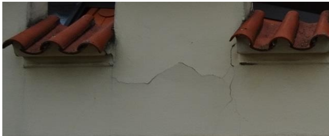
Obrázek 15: Prasklina na fasádě u cimbuří
