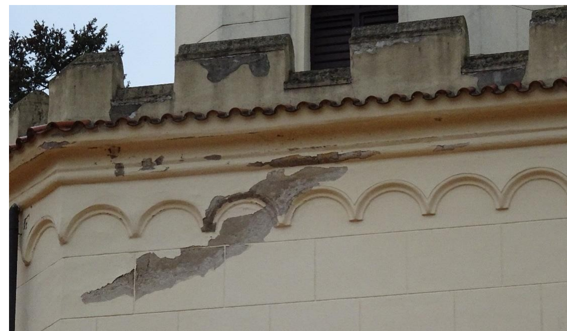
Obrázek 13: Zvětralá fasáda na ozdobné římse
