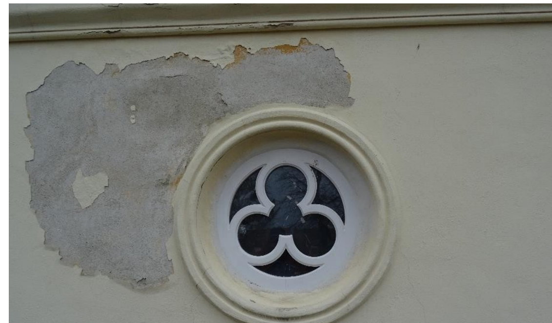
Obrázek 12: Zvětralá fasáda u kruhového rozetového okna
