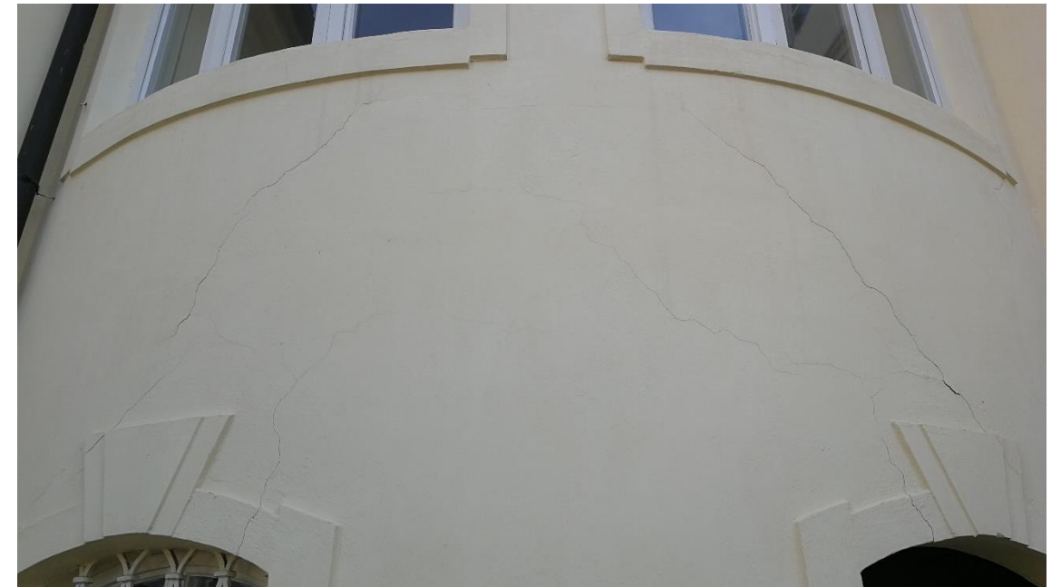
Obrázek 17: Mikropraskliny na fasádě (nádvoří)
